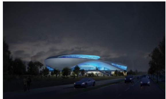
曲江电竞产业园--场馆区项目泛光照明工程
