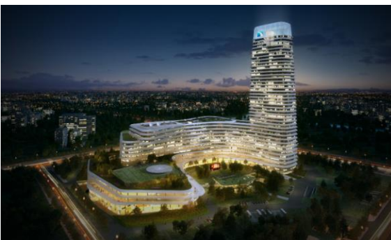
湖北广电大厦泛光照明工程设计施工一体化
