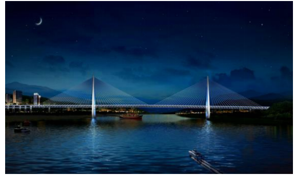
重庆白居寺长江大桥景观灯饰工程
